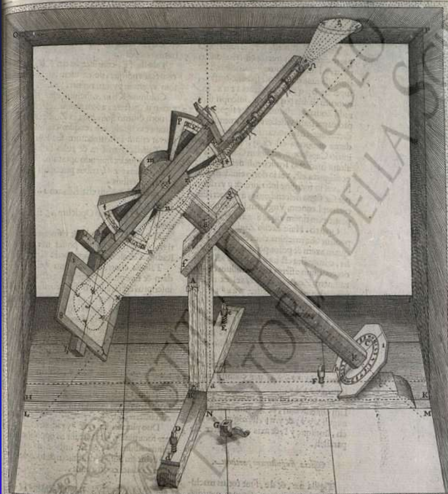
Heliotropii Telescopici, siue Telescopii Heliotropici figura; qua Machina Macularum Cursus absq; ullo perpendiculo, aut laboriosa Ecliptica ad verticalem Circulum inclinatione aquiritur.
